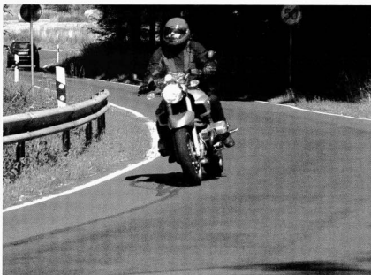
Bislang noch nicht vernünftig repariert worden, ist diese Motorradstrecke in der Eifel. (Foto: Lenzen)
