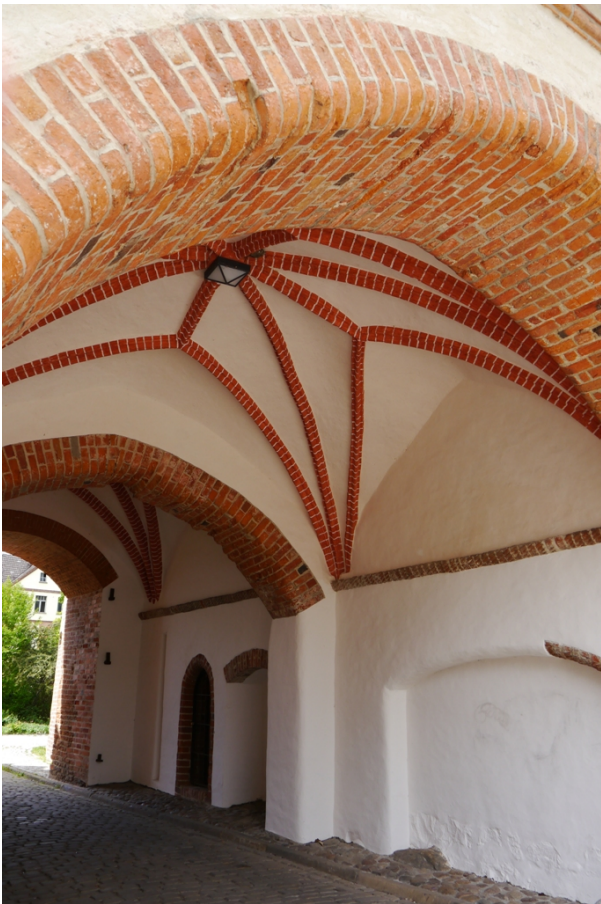
Gardelegen, Sternengewölbe im Salzwedeler Tor
